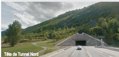
Tête de Tunnel Nord
